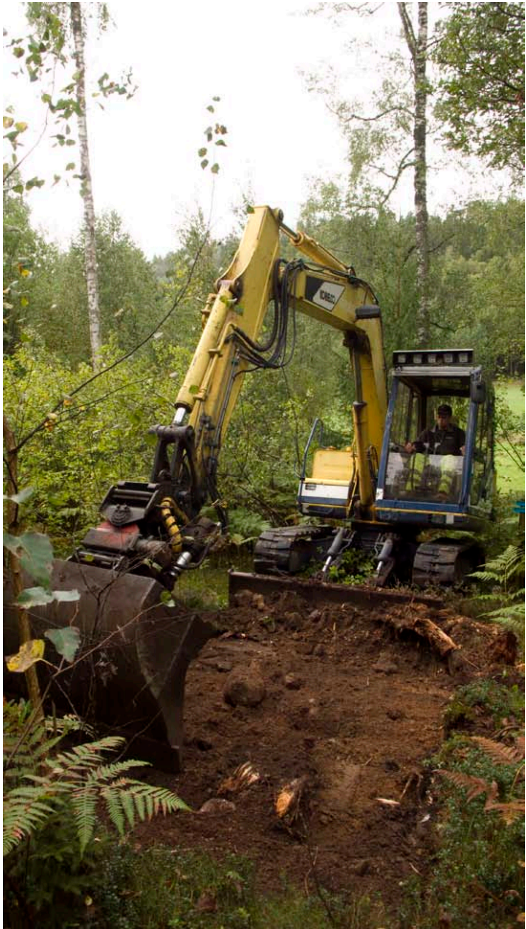
III. 6. Schakt 5 grävs.
