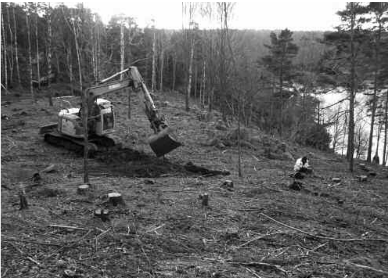
Ill. 9. Boplatsyta 1. Maskinen är i färd med att lägga igen schakt 9 samtidigt som Åsa noterar gräviakttagelserna. Bilden är tagen mot sydväst.
