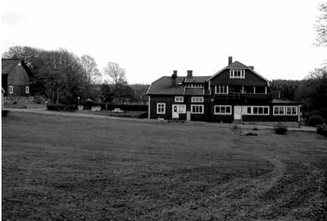
Ill. 1. Huvudbyggnaden för pensionatsanläggningen sedd från norr. I vänstra delen av bilden kan den ursprungliga huskroppen skönjas och till höger ses resultatet av tillbyggnader i flera steg.
