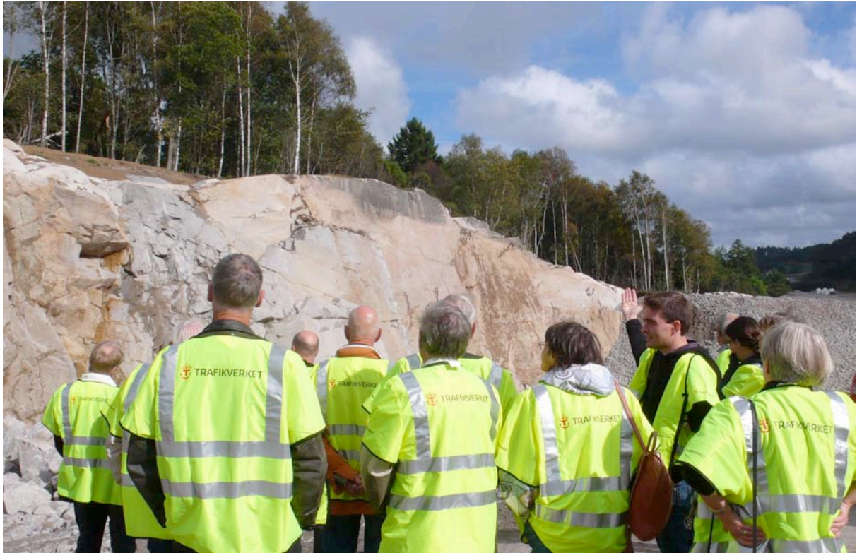
Martin Matsson visar bergsskärningen vid porten till världsarvet i Tanum. Sprängarna har använt sig av sprickbildningen i berget för att få fram en naturligt slät yta. Foto: Annika Östlund.
